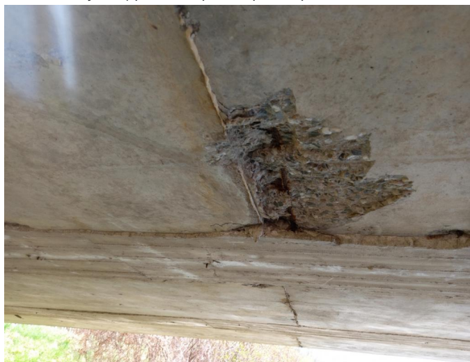
_133118 - na podhledu NK se lokálně vyskytují stopy po zatékání, obnažené třmínky, napadené korozí
