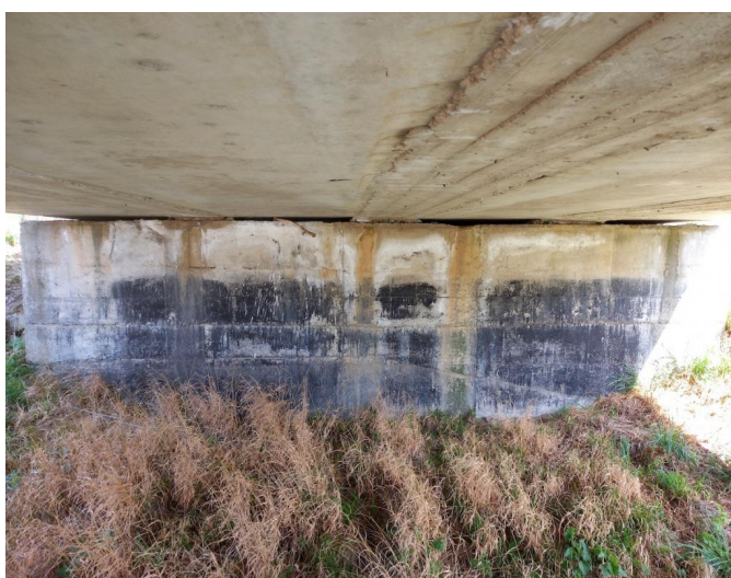
_133000 - na obou krajních opěrách jsou stopy po masivním zatékání
