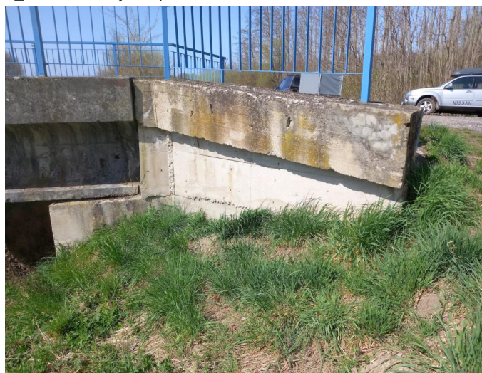
_121466 - místy povrchová degradace povrchů křídel
