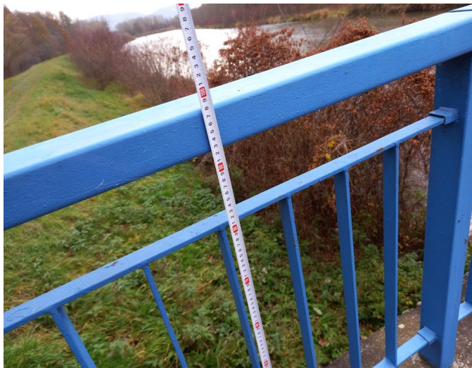
_121616 - výška zábradlí je 1000mm, nesplňuje současné normové požadavky
