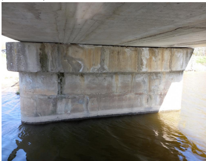
_133734 - místy výluhy na povrchu pilíře P3
