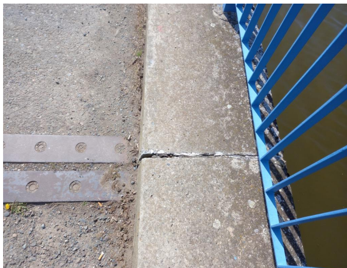
_135401 - tmel spár říms ztrácí přilnavost k povrchu betonu i svoji konzistenci, ve sparách je místy uchycená vegetace
