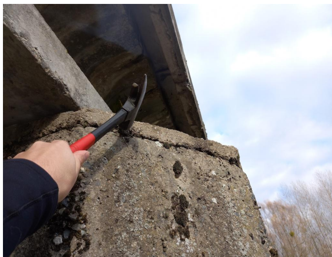
_125859 - odmrzlá přibetonávka úložného prahu pilíře P3
