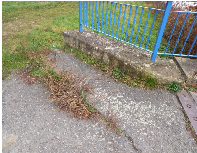
_121547 - výrazná trhlina vozovky na předpolí na konci mostu vpravo, uchycená vegetace
