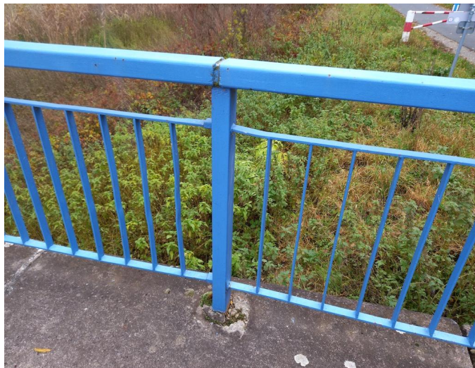
_121811 - na některých sloupcích zábradlí je patrná v místě kotvení korozí (špatně řešený detail)
