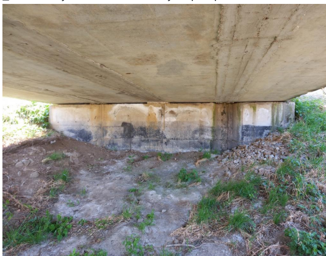
_121480 - na obou krajních opěrách jsou stopy po masivním zatékání
