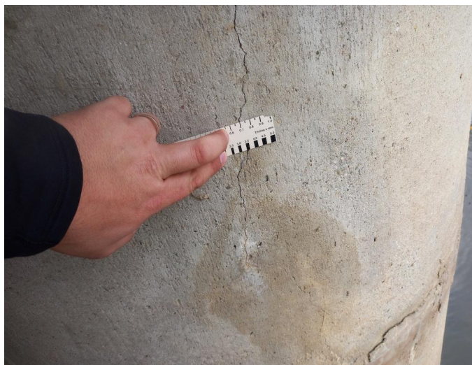
_124214 - svislá trhlina vpravo na pilíři P2, šíře do 0,7mm
