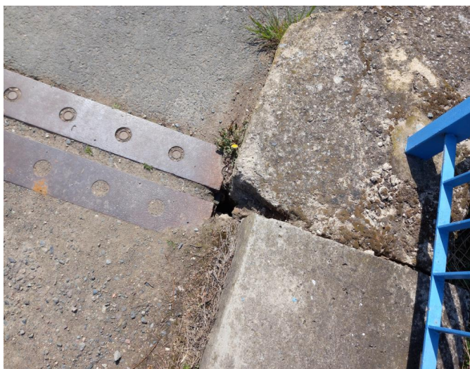
_135457 - otevřená trhлина:kaverna u MZ na konci mostu
