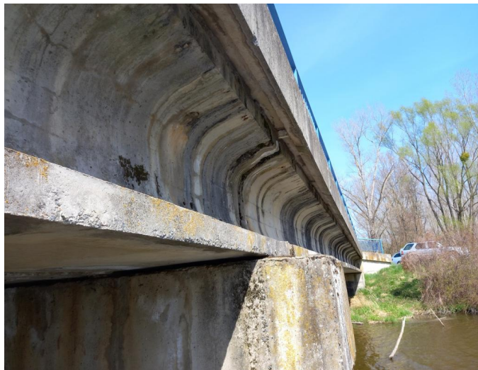
_133829 - stopy po zatékání na boční plochy nosné konstrukce, místy obnažená výztuž, prozatím patrná pouze povrchová koruze
