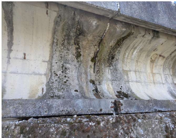
_134353 - stopy po zatékání na boční plochy nosné konstrukce, místy obnažená výztuž, prozatím patrná pouze povrchová koruze
