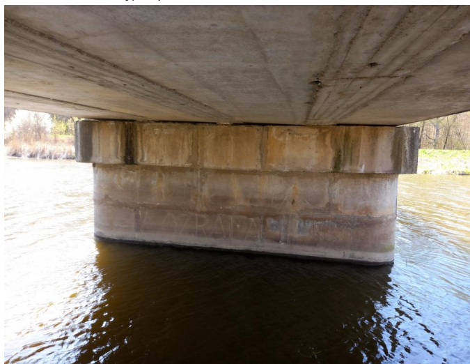
_133313 - masivní zatékání na povrchy pilířů v místech mostních závěrů
