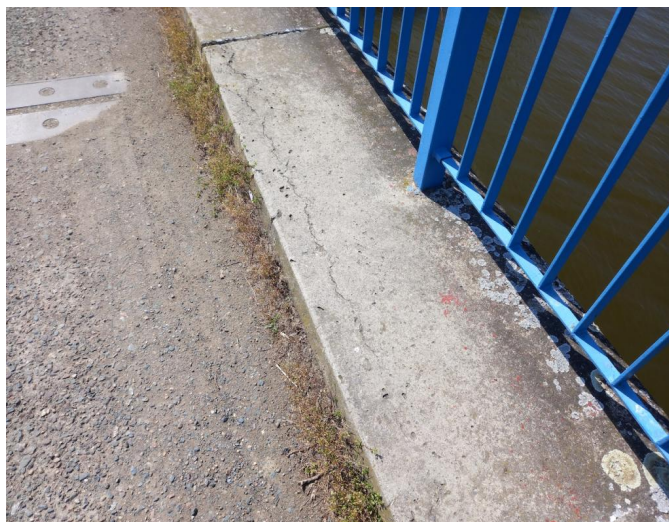
_135430 - tmel spár říms ztrácí přilnavost k povrchu betonu i svoji konzistenci, ve sparách je místy uchycená vegetace
