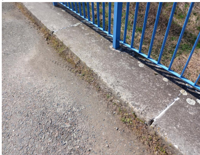
_135448 - podél říms je uchycená vegetace, spára je netěsná (zdroj zatékání)
