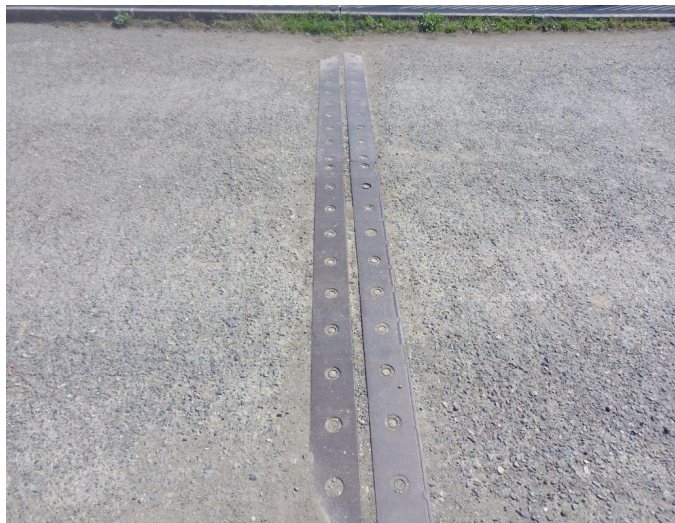
_135435 - mostní závěry jsou netěsné, profily jsou zanešené, bez PKO, povrchová koroze
