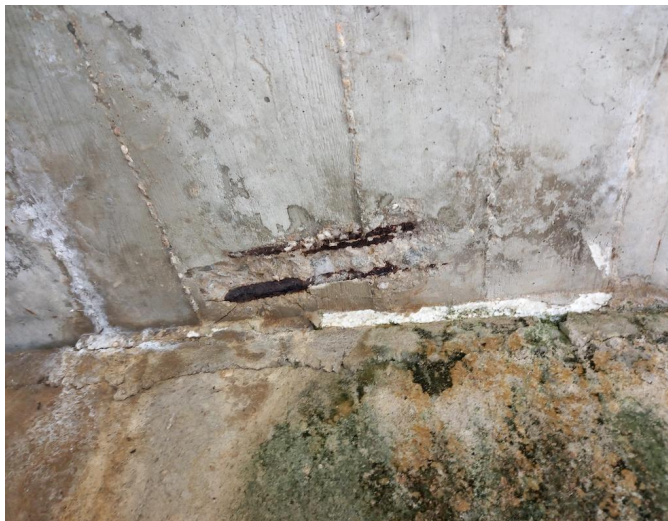
_125724 - na podhledu NK se lokálně vyskytují stopy po zatékání, obnažené třmínky, napadené korozi
