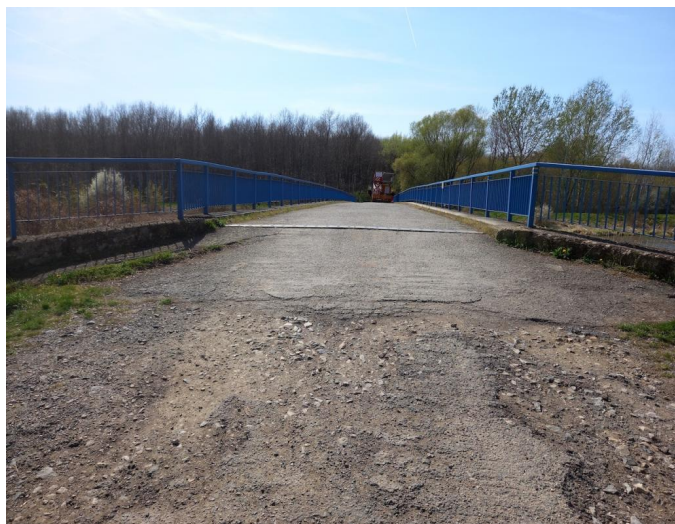
_255846 - degradovaný a nerovný povrch vozovky zejména na začátku mostu
