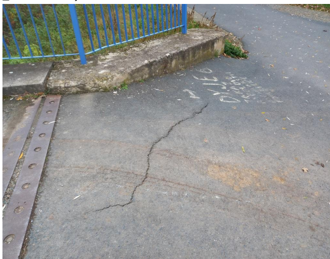
_121456 - výrazná trhlina vozovky na předpolí na konci mostu vlevo
