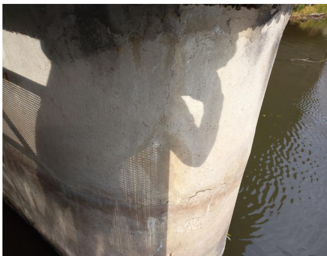
_124154 - svislá trhlina vpravo na pilíři P2, šíře do 0,7mm
