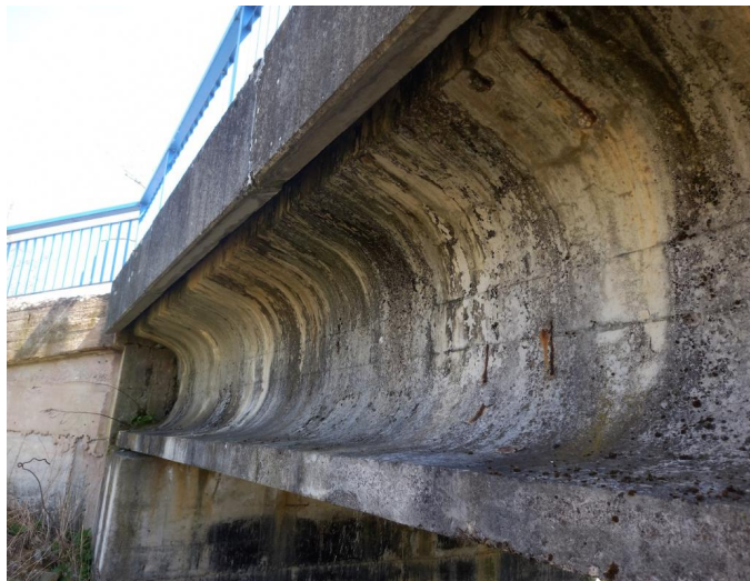
_133029 - stopy po zatékání na boční plochy nosné konstrukce, místy obnažená výztuž, prozatím patrná pouze povrchová koroze
