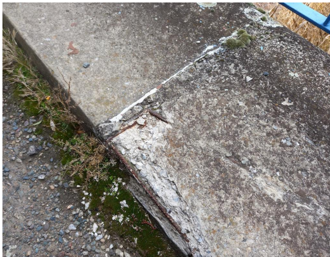
_122006 - lokálně hloubková degradace povrchu pravé římsy, obnažená výztuž, korozí
