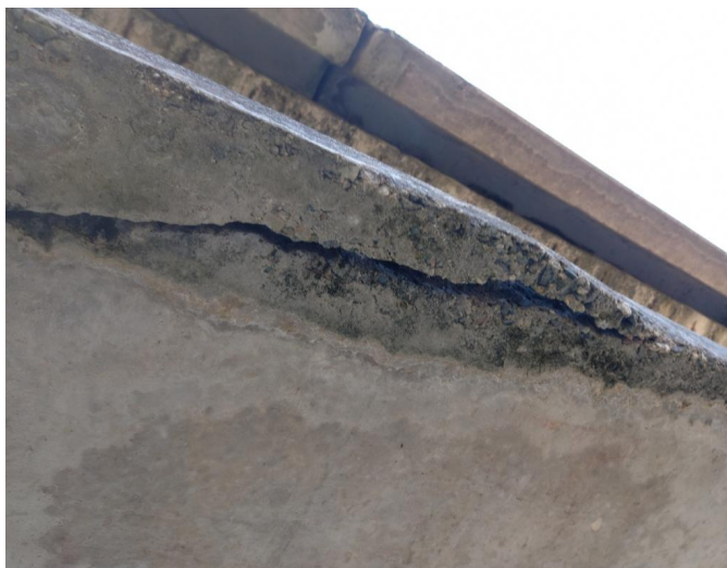
_133110 - v poli 1 odtržená hrana pravého nosníku
