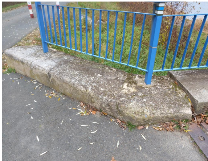
_122108 - výšková deformace předpolí pravé římsy na konci mostu, rozdíl až 80mm
