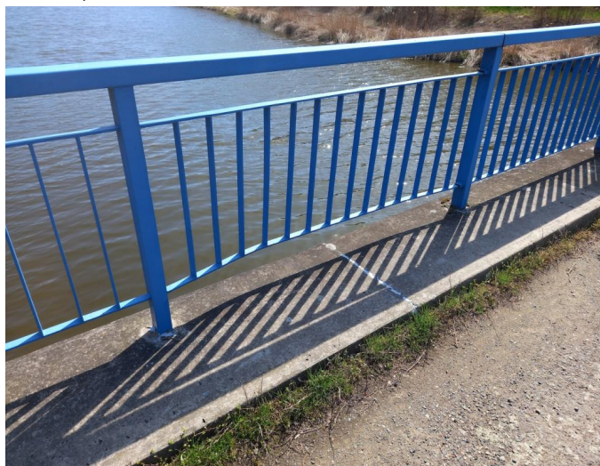
_135706 - deformace jednoho pole levého zábradlí
