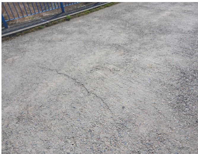
_135439 - obecně se na vozovce objevují nepravidelné trhliny
