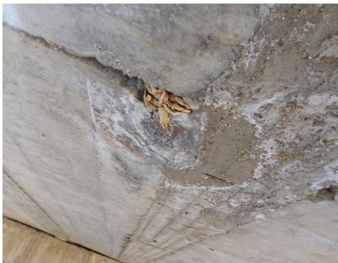
_133301 - na podhledu NK se lokálně vyskytují stopy po zatékání - prozatím malý rozsah
