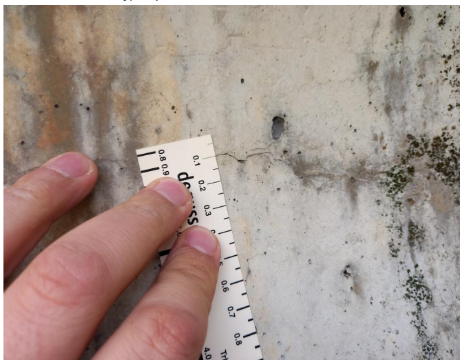
_130703 - místy se na bočních plochách NK objevují drobné trhliny šíře do 0,1mm
