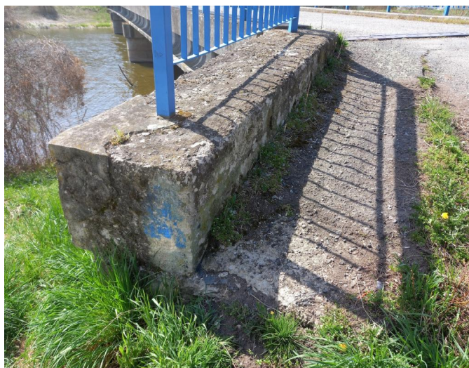
_135217- římsy, zejména na křídlech, povrchově degradují
