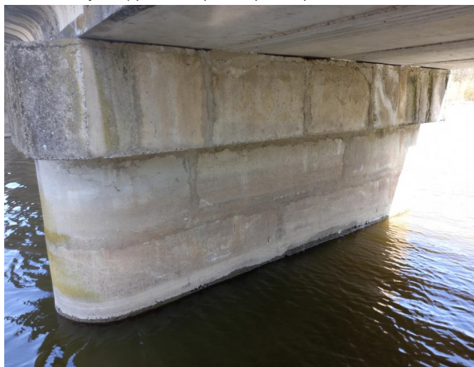
_134709 - drobná, spíše povrchová degradace povrchů pilířů ve styku s vodní hladinou
